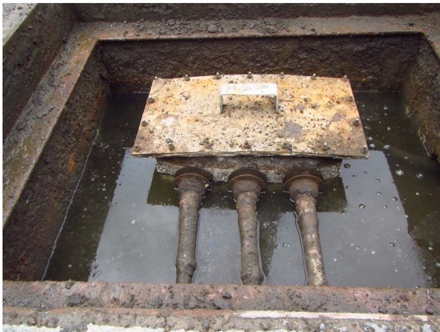
колодец транспозиции, расположенный на болоте
